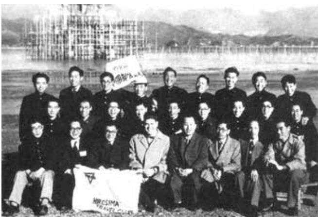
1950年11月 学生Y M C A中国部会の記念写真。指導の一環で広島（宮島）を訪れたディーン・リーパー氏（前列中央）背景には1950年9月のギニア台風により破損した宮島の大鳥居の修復工事が映っている。
