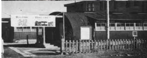
1949年12月21日 軍用兵舎コンセットハット2棟が落成
