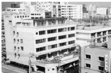
1974年11月11日 社会福祉事業団の融資を受け、新館（現2号館）落成。2階を保育園として使用。
